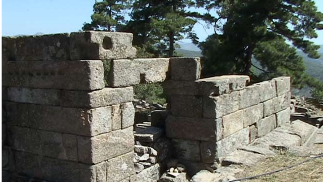
Andrôn B : vue de l'arrière du bâtiment et de la niche qui se projette en deçà du mur de fond.
