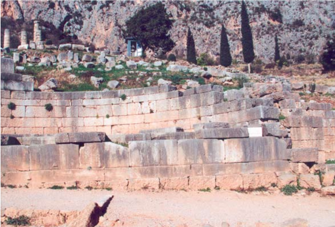
Situation du monument : vue vers le nord-est. à droite, le portique Atlas 108.
