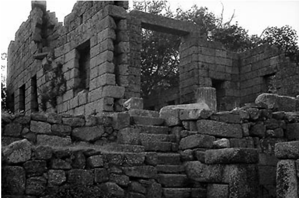
Vue de l' andrôn A prise en contre-plongée (l'escalier au premier plan est moderne). Remarquer les quatre fenêtres percées dans le mur sud particulièrement bien conservé : cette vue permet de comprendre le mode de construction des murs doubles ( www.losttrails.com ).
