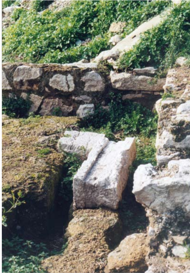
Bloc de calcaire présentant un creusement au lit d'attente permettant de loger une barrière.
