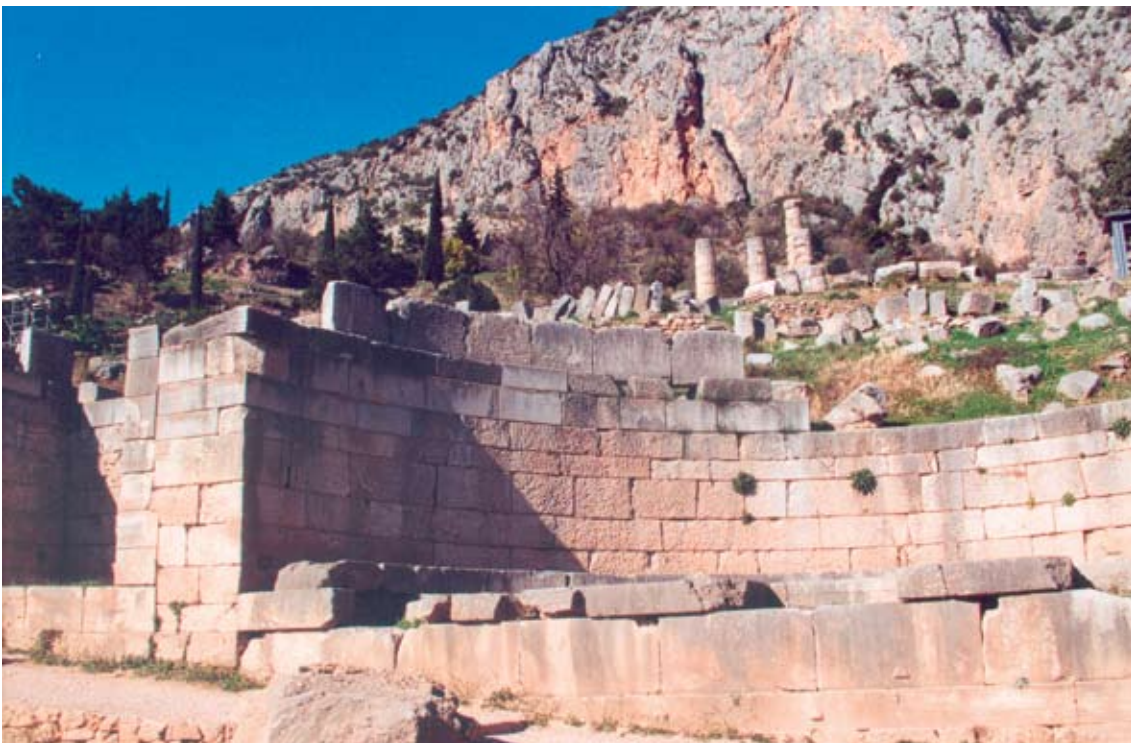
Vue principale : vue vers le nord-ouest. A gauche, la niche «carrée» Atlas 115.
