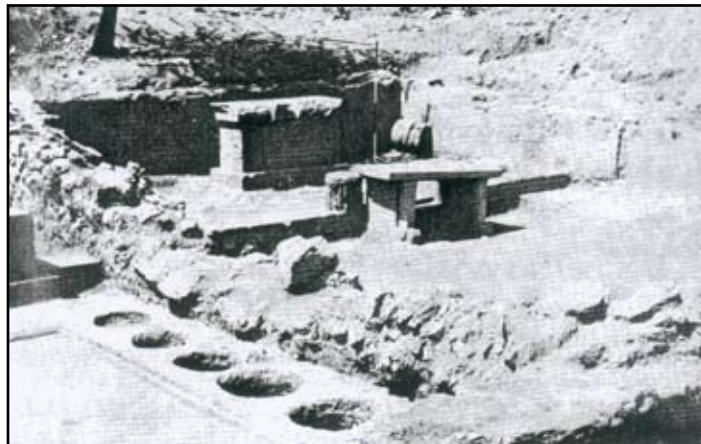
Pièces 4 et 5 : base pour un second groupe sculpté (?) au fond de la pièce 4 ( Deltion 17, 1961-1962).
