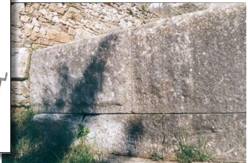
Au delà du point de jonction entre le péribole nord et le mur ouest du monument, les orthostates du podium n'ont pas été ravalés car ils n'étaient pas visibles depuis l'intérieur du téménos .
