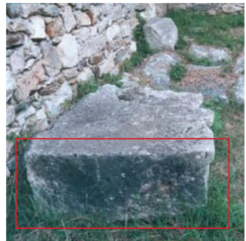
Pas de cadre d'anathyrose sur cette face latérale : le bloc peut donc être replacé à l'extrémité gauche du monument.
