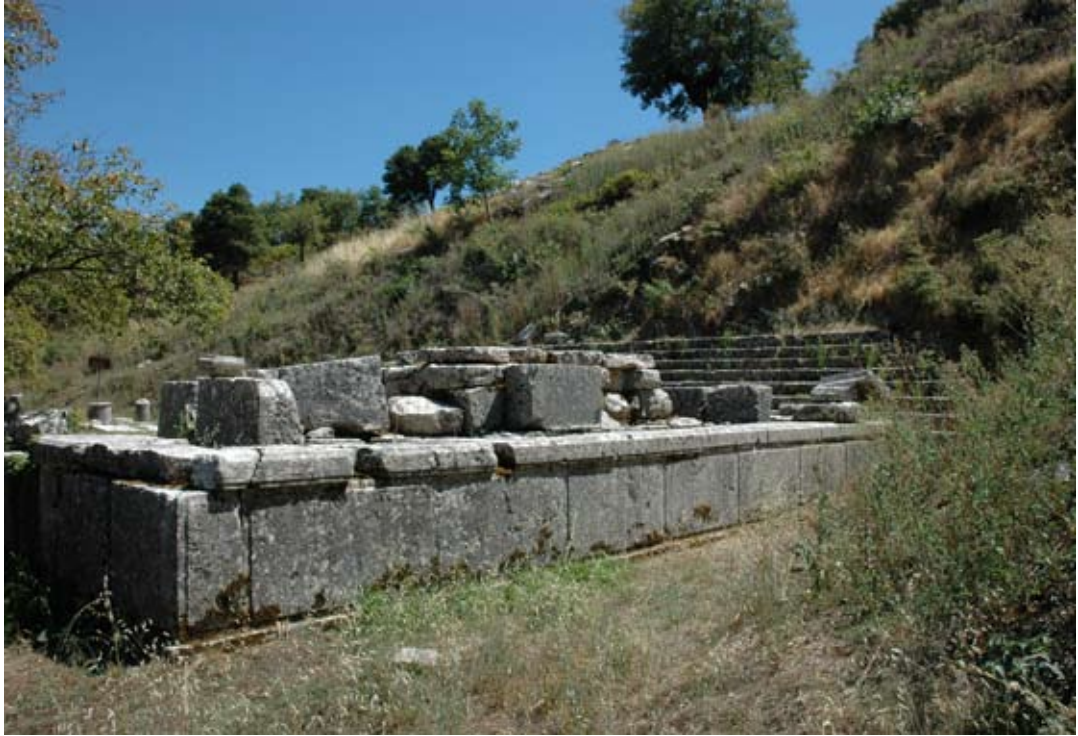
Mur de fond du temple de Despoina, pris depuis l'angle N-O (J. Montel, état été 2006) : on distingue nettement le travail de ciselure des orthostates et du rang de blocs isodomes qui les couvrait.
