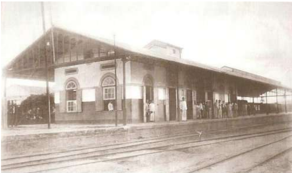
Figura 19 - Primeira Estação de Alagoinhas/BA, Bahia and San Francisco Railway , provavelmente da década de 1910, autor desconhecido.
