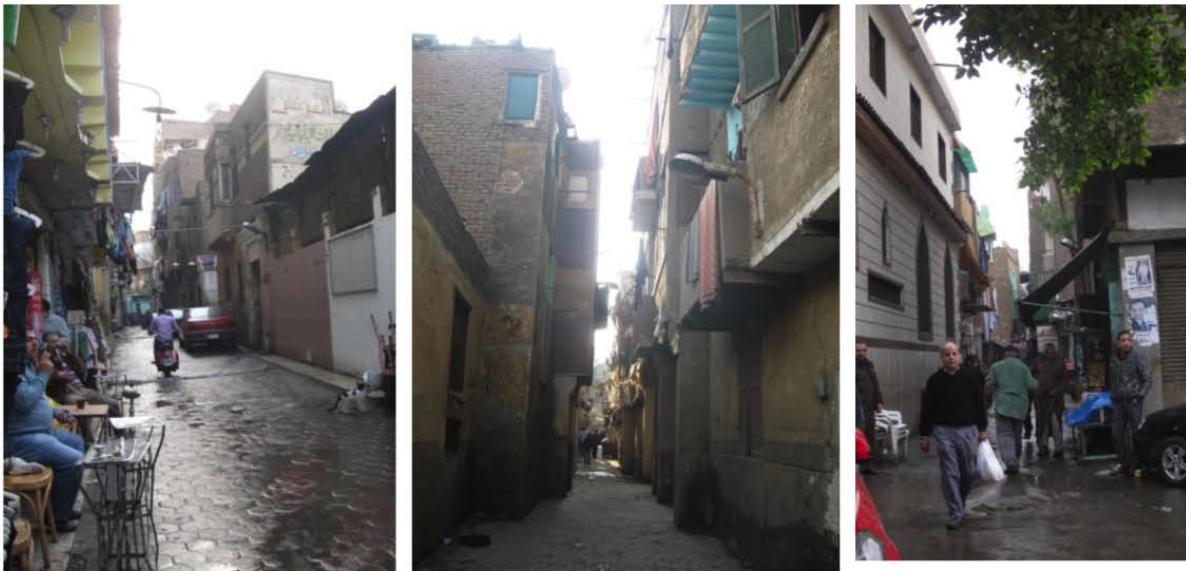
Figure 13. Localisation et voirie du triangle Maspero: ses “entrées”, autrement dit les petites ruelles que depuis les grandes artères conduisent à l’intérieur du quartier, ont joué un rôle fondamental dans les soulèvements de janvier 2011.
