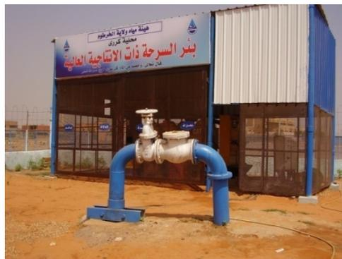
Photographie 34 : Forage-relai (profondeur 70m) alimenté par un générateur, pour la desserte d'environ 70 blocs à Al Thawra, Omdurman
