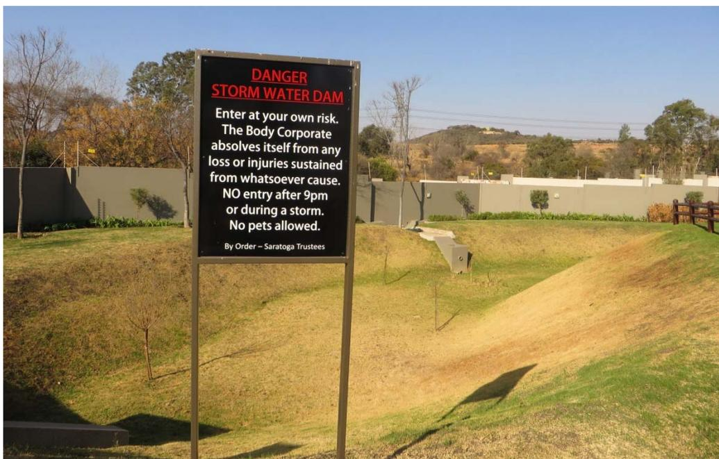
*Photographie 26 : Bassin de rétention intégré à la résidence Saratoga, réalisée par Summercon.
