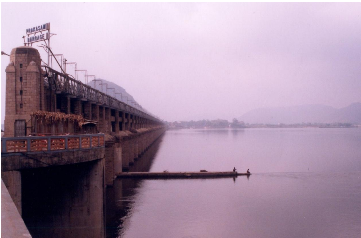
Photo 1 : Barrage de Prakasam sur la Krishna à Vijayawada
