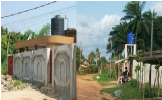
Les bacs noir et bleu en haut des habitations sont un des éléments du système d'approvisionnement en eau potable dans la périphérie (Abomey-Calavi et Sèmè-Podji). Le tuyau est relié au puits d'où l'eau est tirée par un appareil électrique. Photo n°7, M. CHABI
