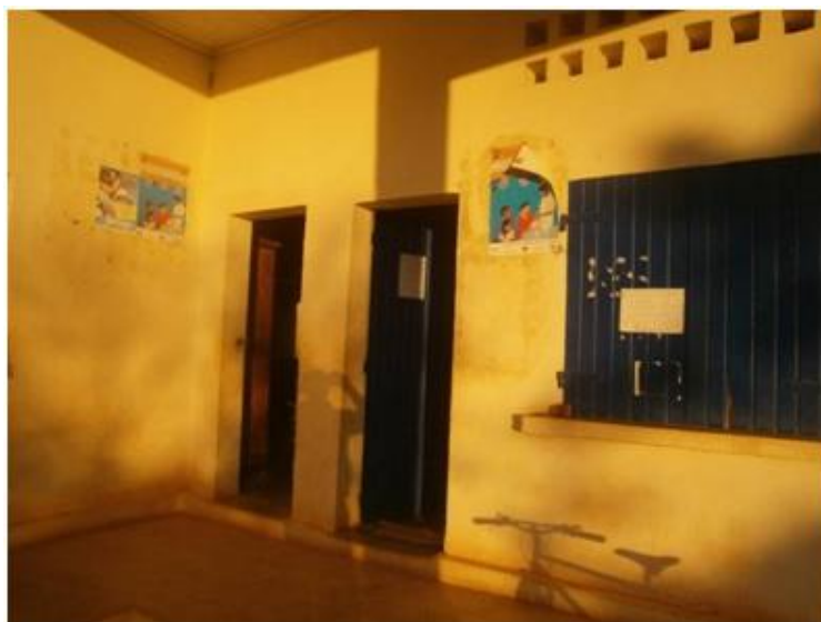
Photographie 68 : Le CSB 2 de Pont-Sofia
