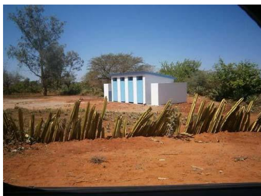
Photographie 57 : Les latrines de Bélindo
