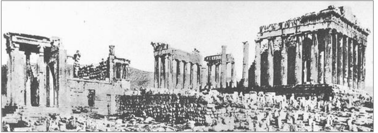
Fig. 185 : L'Acropole avant les travaux de Mpalános (1898)
