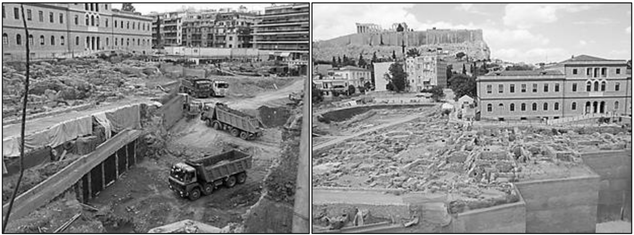
Fig. 3 : Construction du Musée de l'Acropole (2004-2006)
