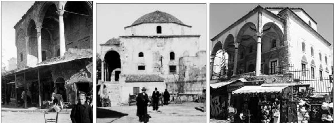
Fig. 264 : Tzisdarákī Tzamí avant (1905) et après la restauration d'Orlándos (2011)
