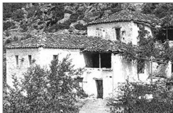
Fig. 18 : Maisons paysannes avec doxátos/chayiáti (Kremastī en Laconie)
