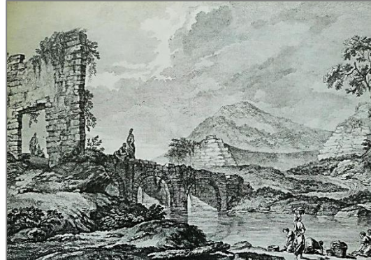
Fig. 55 : Le Pont de l'Ilisós et le Stade (Le Roy 1755)
