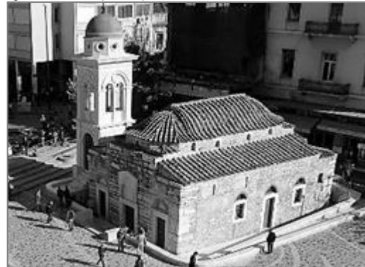
Fig. 242 : Église Pantánassa après les travaux de restauration
