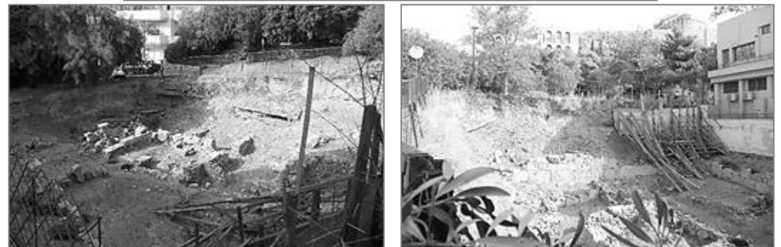
Fig. 218 : Maisons Romaines après les travaux de l'E.A.X.A (2013)
