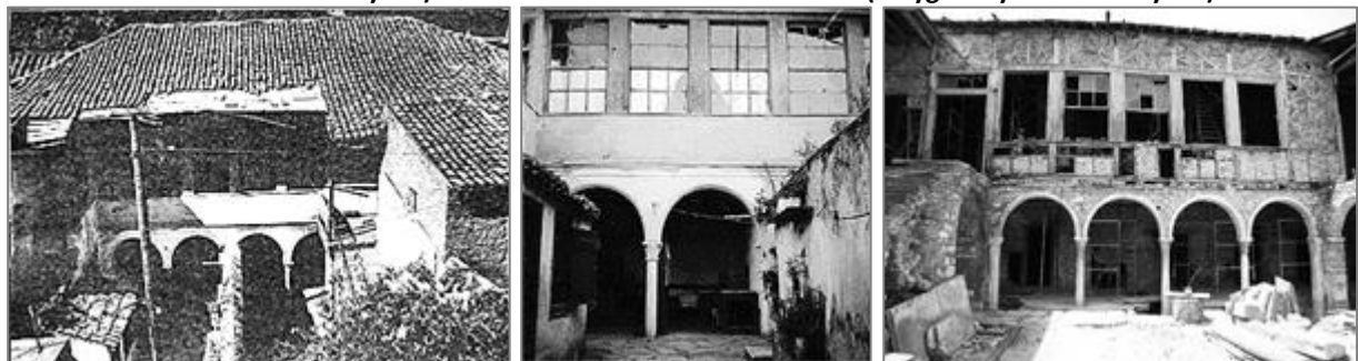
Fig. 280 : Archontikó Mpénizéloy avant (1946) et pendant les travaux (2008)
