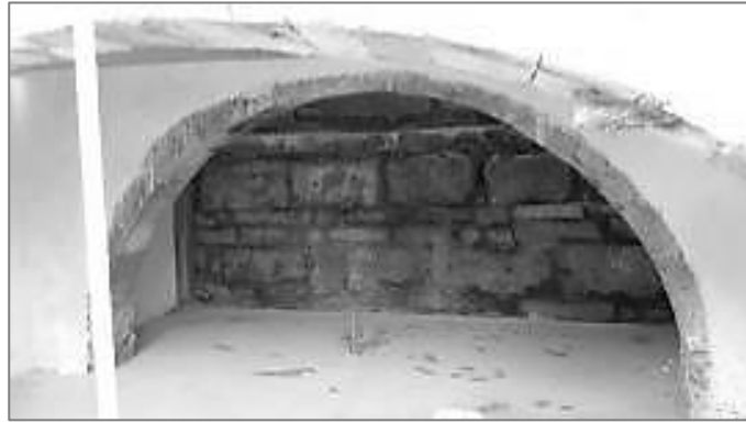
Fig. 289 : Edifice du Vryssakíoy 3 avec la partie basse du Mur dit de III e siècle avant (2013) et après les travaux (2016)
