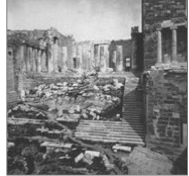
Fig. 173 : Le versant ouest après l'anastylose des escaliers (1860) 1087
