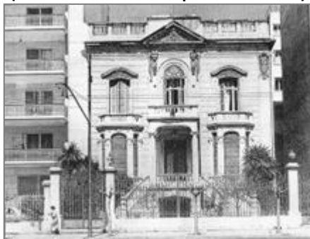
Fig. 6 : Oikía Vóglī détruite en 1968 (Vasilíssis Sofías 35)
