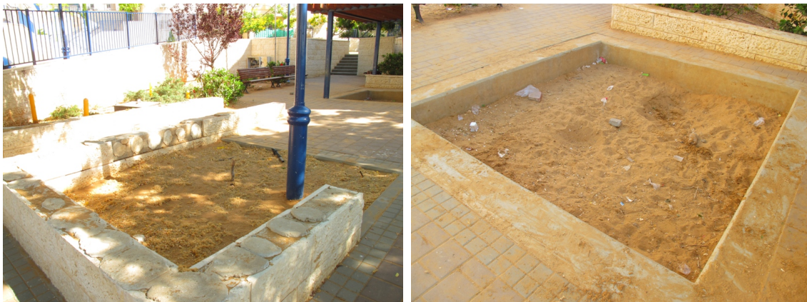
Photos 19 et 20 Bacs à sable dégradés et abandonnés (Elad, 2012)
