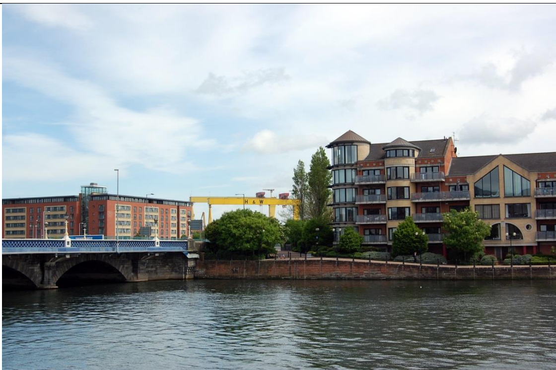
Photo 2 : Rive droite, avec en arrière-plan les grues du chantier naval Harland & Wolff – nommées respectivement Samson et Goliath – où se trouve aujourd'hui le Titanic Quarter.
