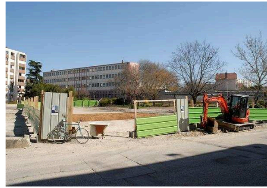
Pose des barrières de la pépinière 153
