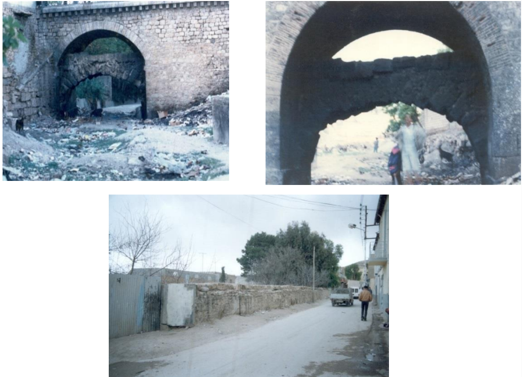
Photo n° 15: l'état actuel de l'aqueduc de Tébessa en 2021.
