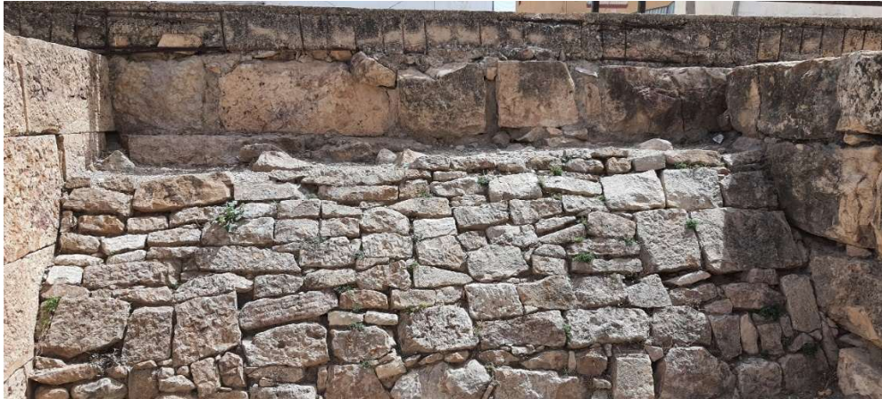
Figure 17 Comparaison entre l'appareillage du mur de la chapelle de Gabinilla et celui de l'enceinte byzantine. Au centre et à droite : enceinte et mur de renfort byzantins. À gauche : mur de la chapelle de Gabinilla. F. Z. Boughanem, 2021
