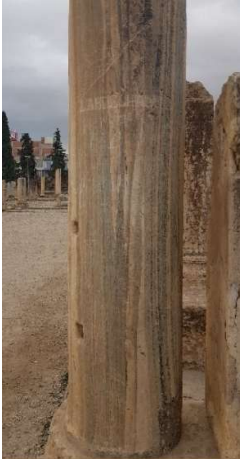
Colonne lisse en marbre
